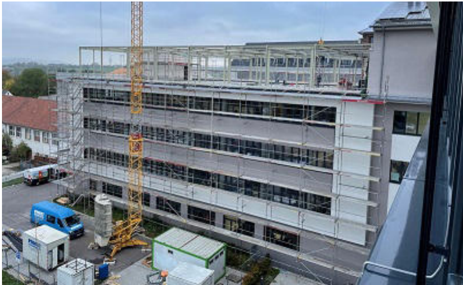
Die Aufstockung des Gebäudes A des Karl-Kurz-Gebäudes läuft planmäßig (Bild Stand Oktober 2022)
