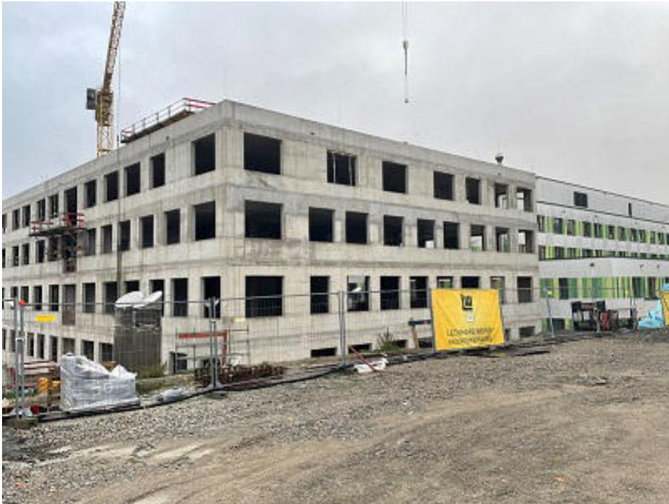
Der Rohbau des Klinikbaus in Crailsheim wird im Dezember 2022 fertiggestellt. Das Bild entstand Anfang Oktober.
